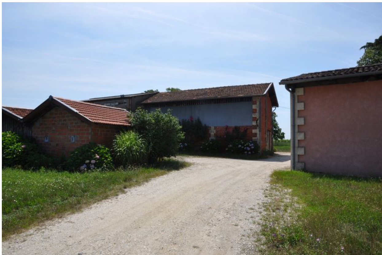
Ecurie-grange et anciens chais : façades nord.
