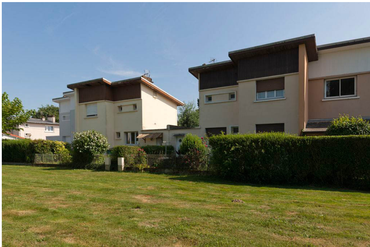
Maisons jumelles de la cité de Pondix
