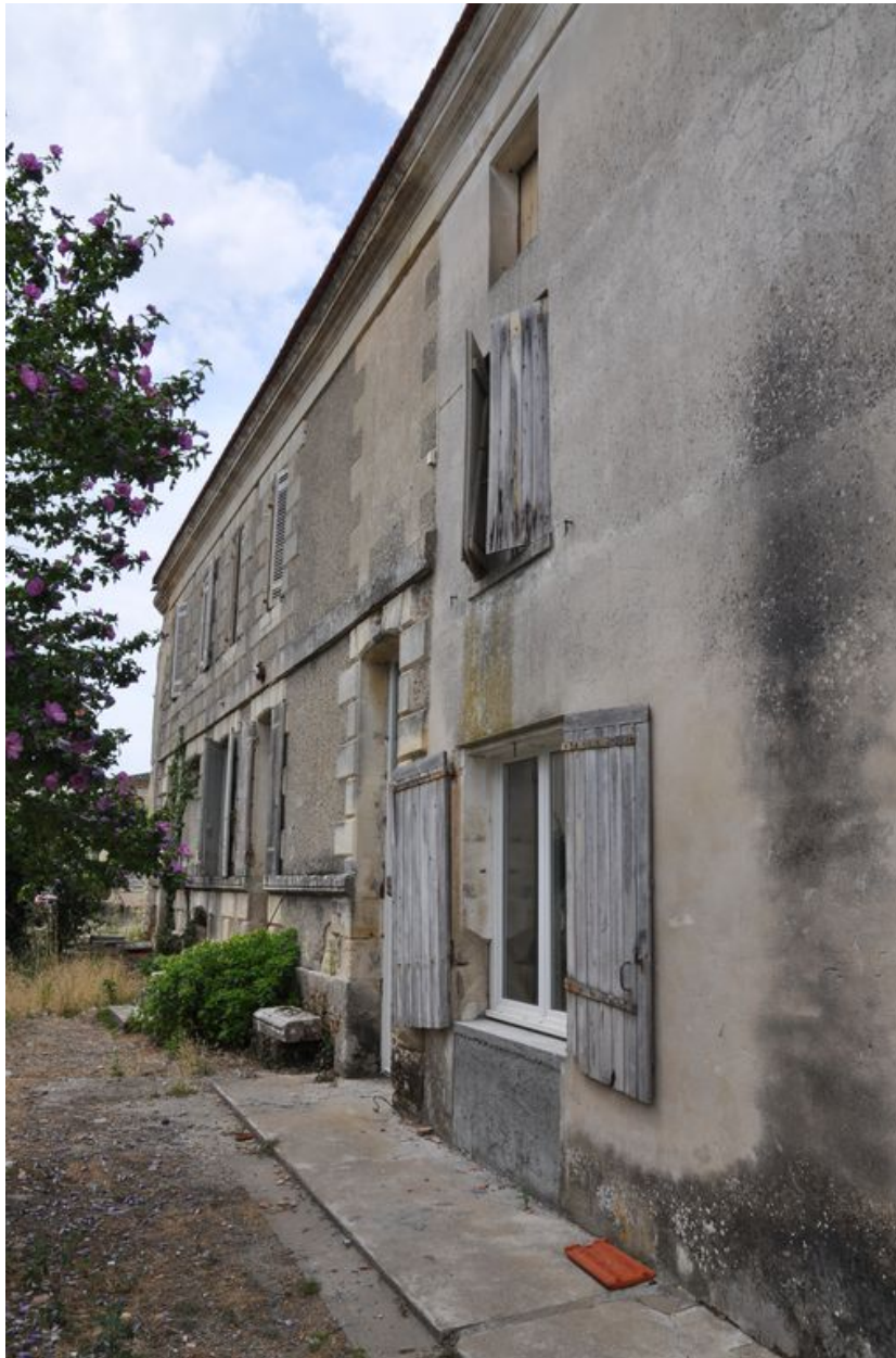
Vue de la façade depuis l'est.
