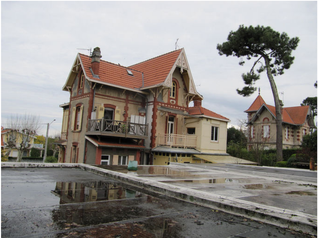
Elévation postérieure depuis l'allée des Marronniers.
