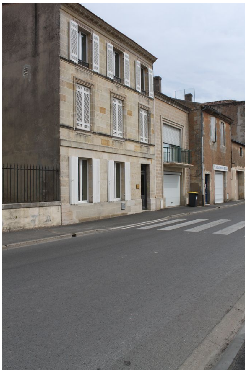
Façade ouest, sur le cours.
