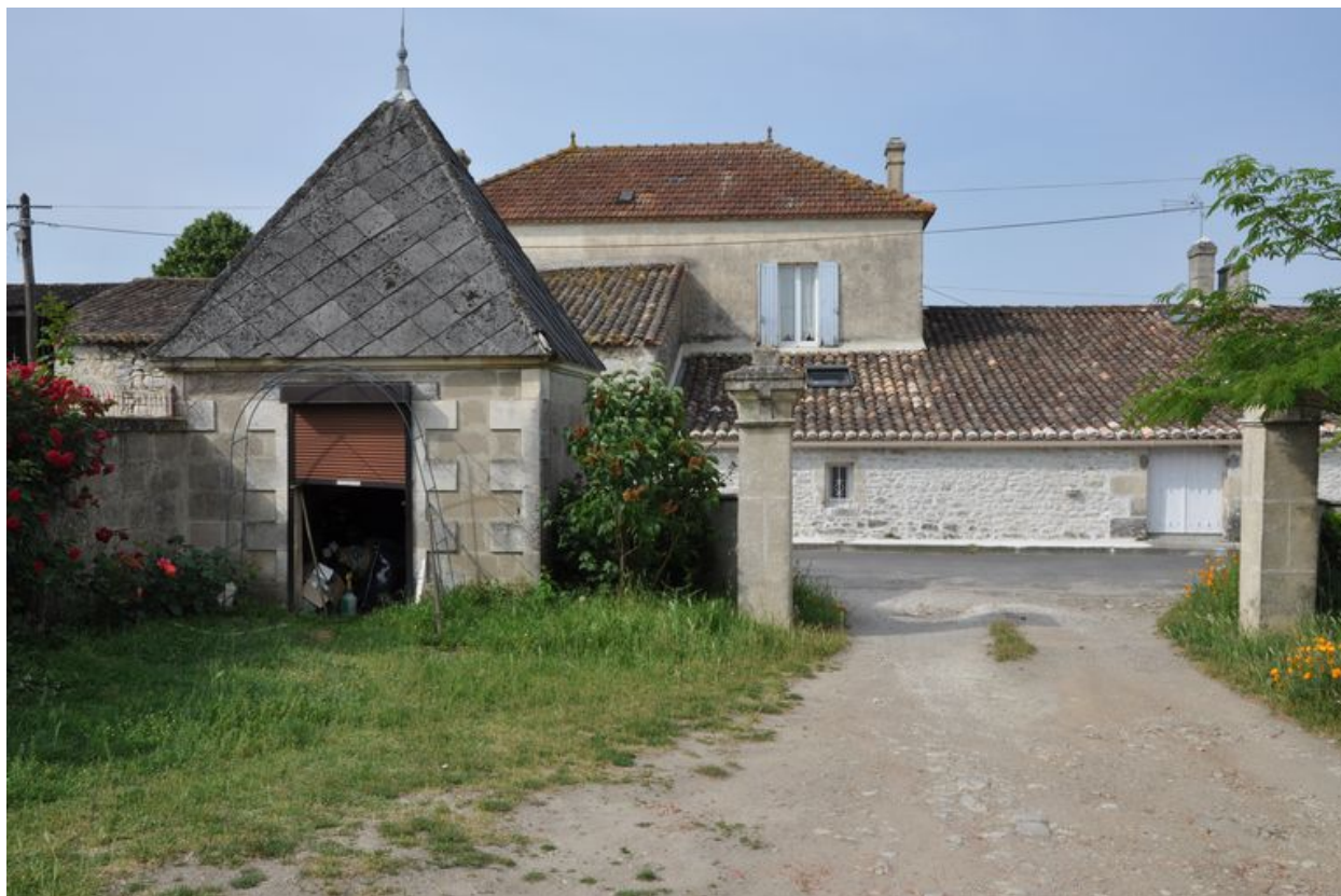
Resserre dans la cour.
