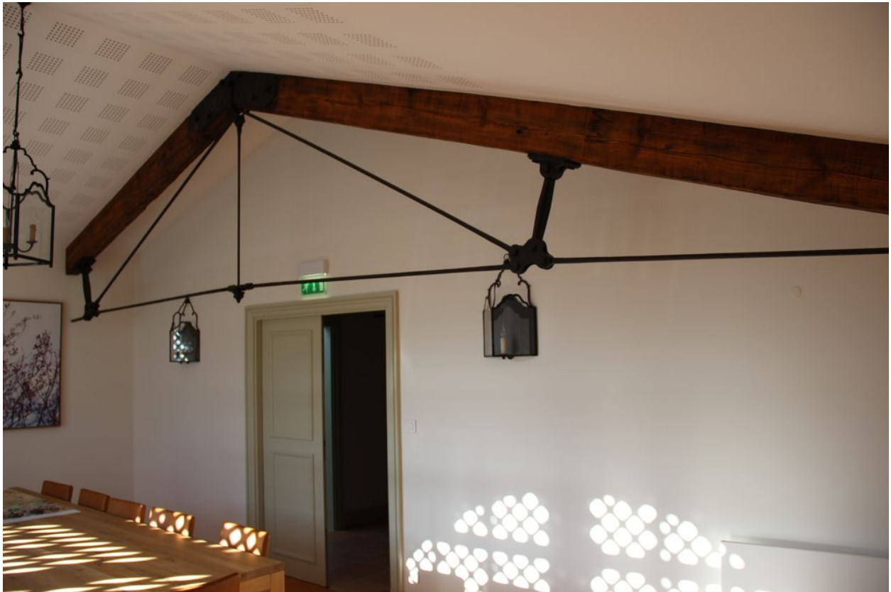
Ancien cuvier, vue intérieure : charpente à tirants métalliques.
