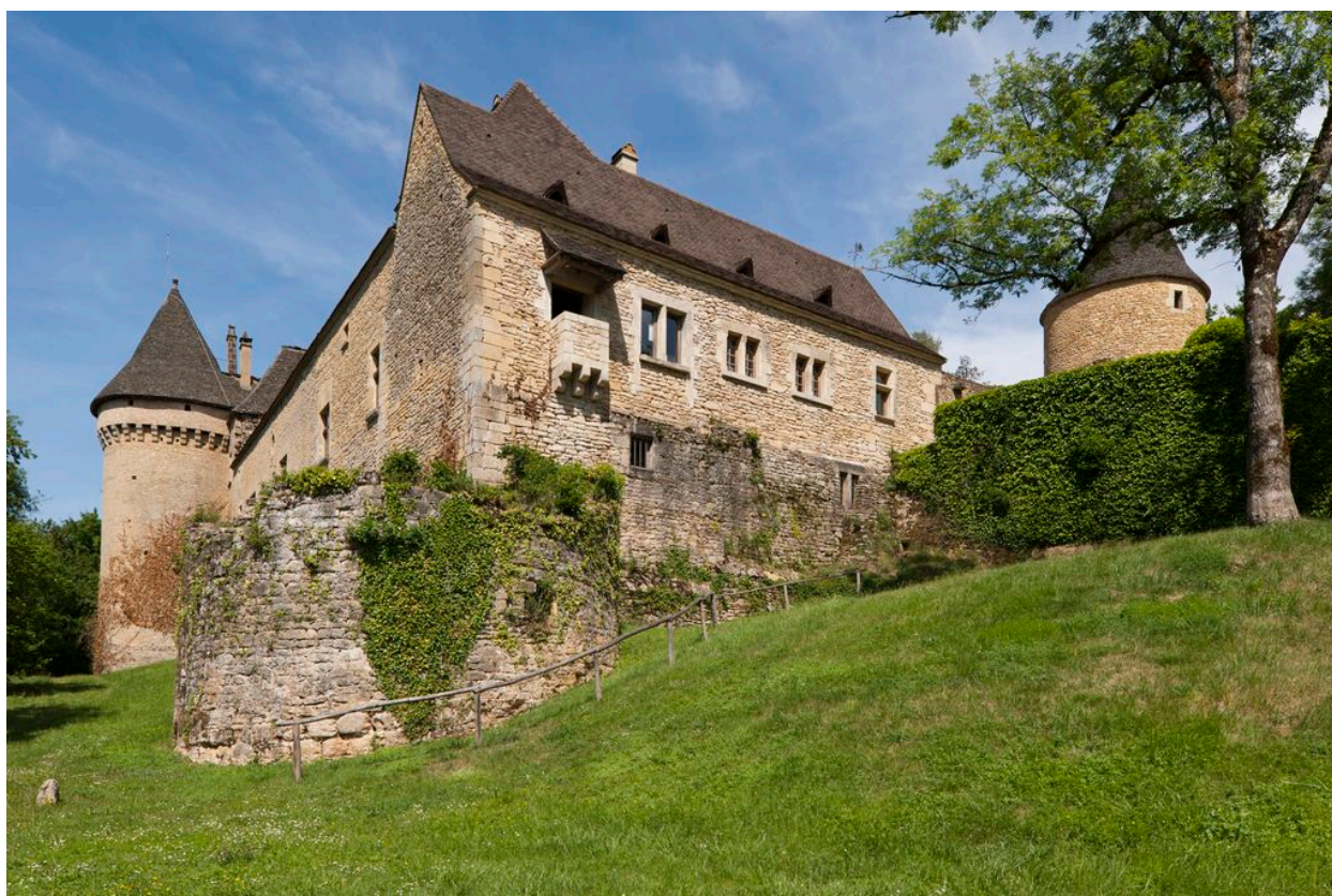
Vue d'ensemble de l'ouest.
