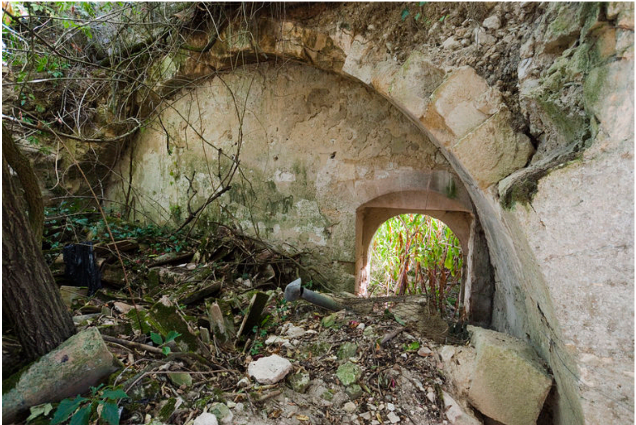
Vestige d'une salle voûtée (sud-ouest).
