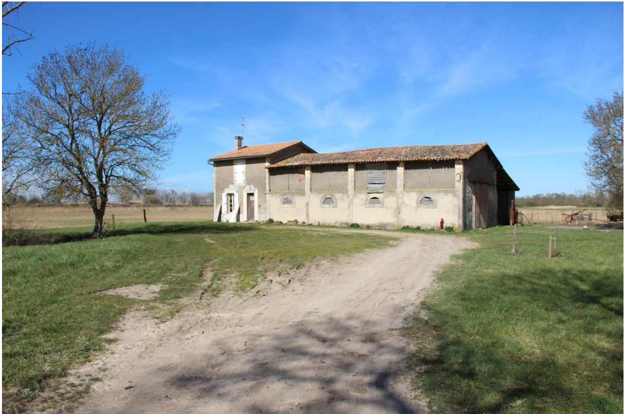
Bots Lantons : ferme avec grange-étable de la fin du 19e siècle, située dans la palus de Saint-Genès.
