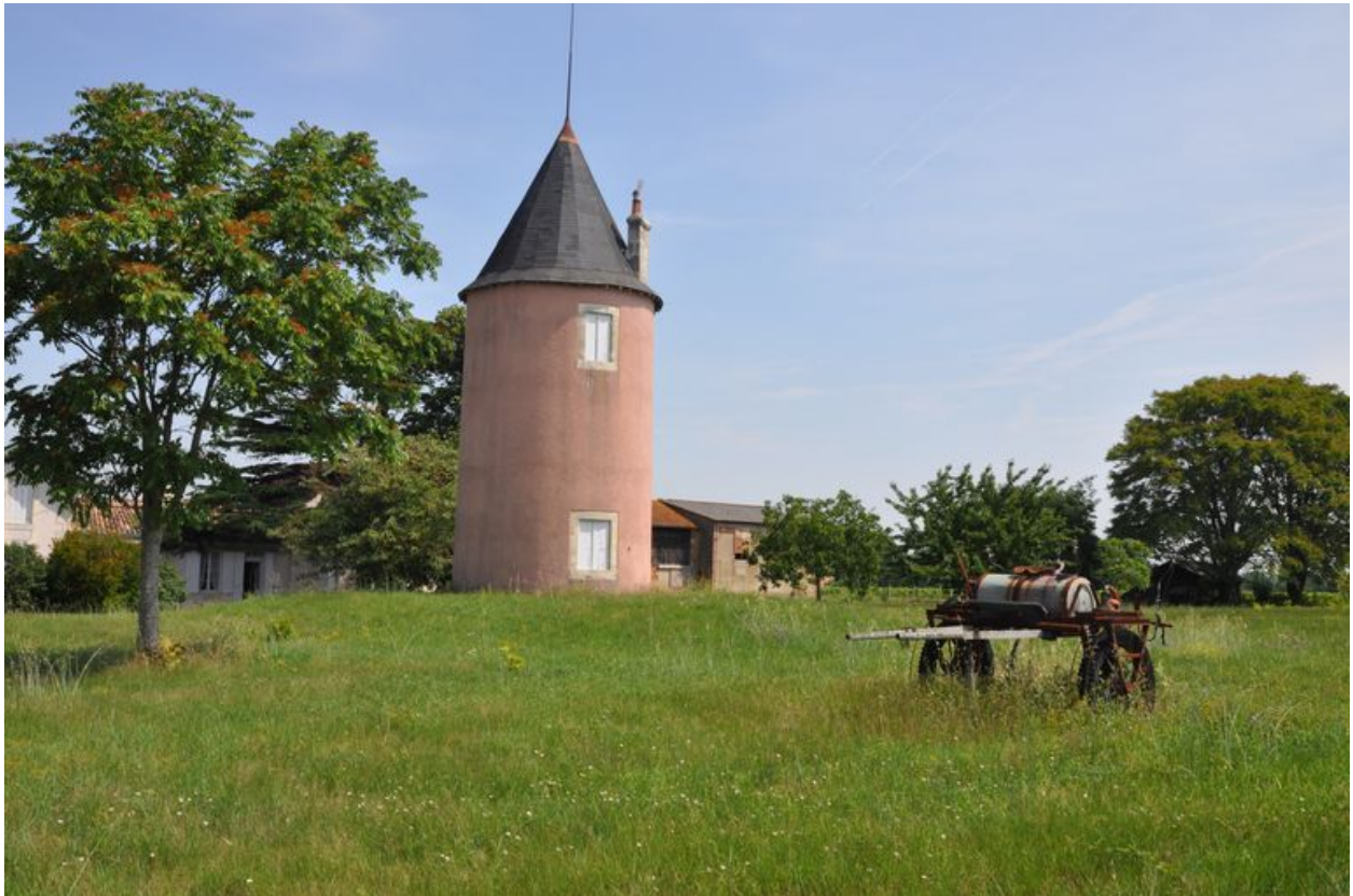
Vue d'ensemble avec le moulin.
