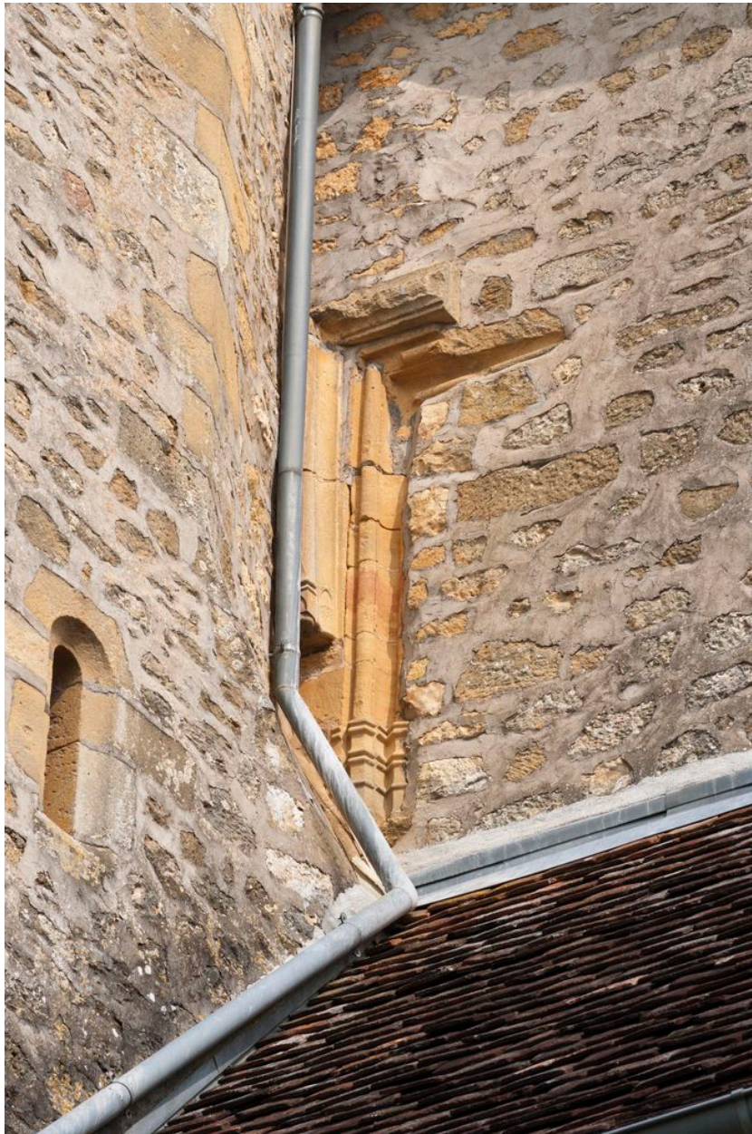
Détail d'une fenêtre (croisée ou demi-croisée) murée dans la maçonnerie de la tour d'escalier.
