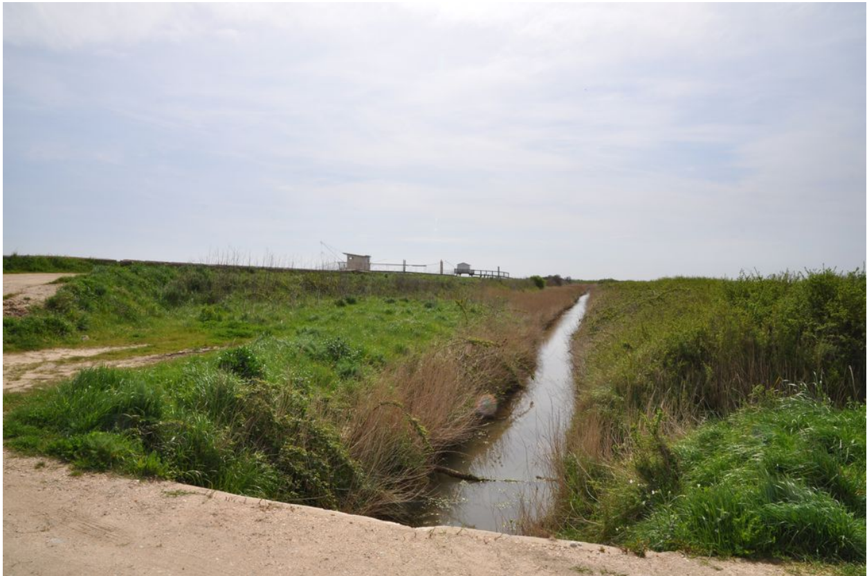
Fossé de drainage.
